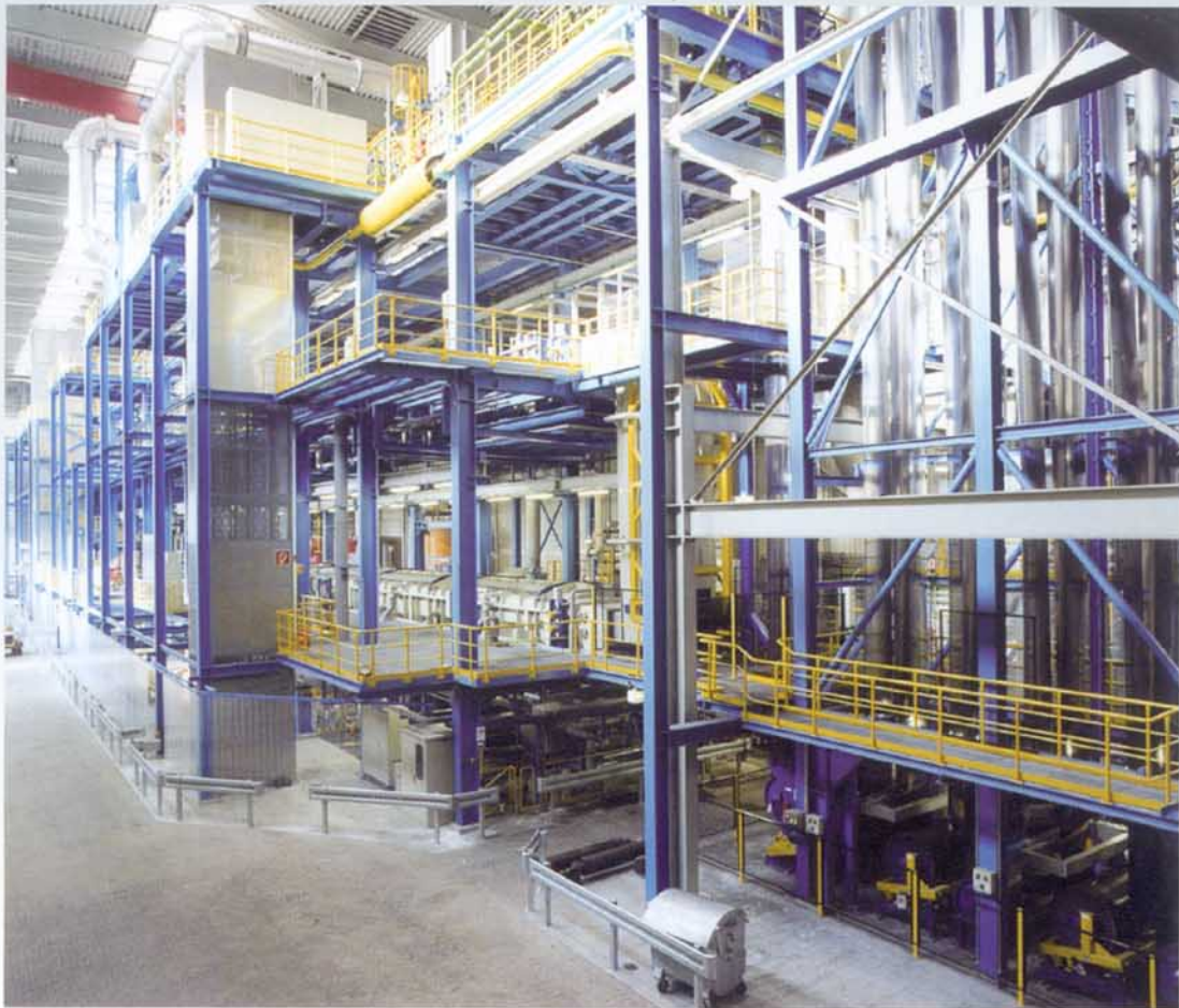
ThyssenKrupp Nirosta Krefeld - Kaltbandlinie - komplett bestückt mit MITEX Rollenbeschichtungen
